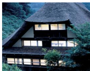
多層民家 (田麦俣集落内)
